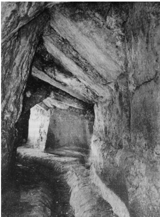
-- Ondergrondse tunnel van het hoogniveau aquaduct Deze tunnel bevindt zich tussen El Biar en de vijvers van Salomo . --
